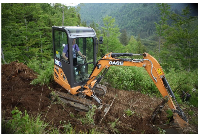
Fig. 13 Small excavator filling up ravines in Podul Încurcat
